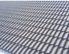
Tekking (med tilhørende beslag) - Taktekking
