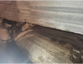
Tilsig av vann og fuktsperre mot grunn - Tilsig fukt krypkjeller
