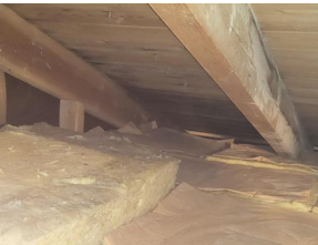
Synlige overflater (taktro, vegger, gulv, o.l) - Misfarging undertak
