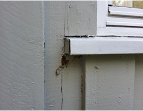
Ytterkledning (fasademateriale, vannbord, utvendig listverk, o.l.) - Råteskade ved vindu spisestue
