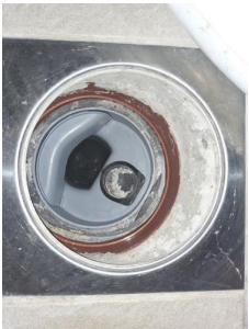
Tettesjiktets tilslutning til sluk - Sluk
