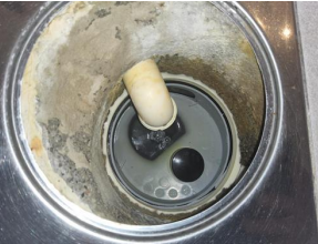
Tettesjiktets tilslutning til sluk - Hovedsluk
