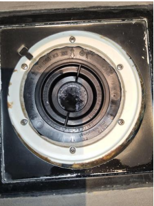
Avløp (inkl. sluk) - Sluk baderom 2.etasje dusjsone
