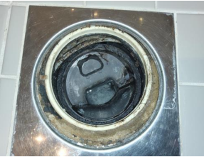
Tettesjiktets tilslutning til sluk - Sluk
