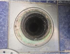
Vanntett sjikt / membran i gulv og vegger - Sluk under dusjkabinett i baderom 1 etasje.
