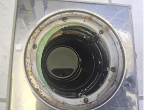
Vanntett sjikt / membran i gulv og vegger - Sluk i baderom 2 etasje.
