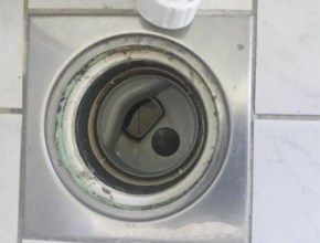
Vanntett sjikt / membran i gulv og vegger - Sluk under dusjkabinett i baderom 2 etasje.
