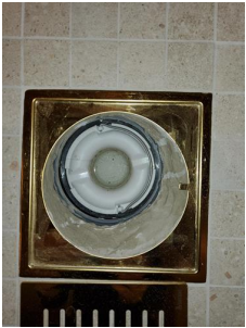
Tettesjiktets tilslutning til sluk - Sluk Baderom 1.etasje.
