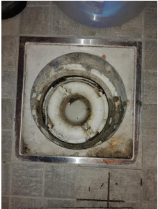
Tettesjiktets tilslutning til sluk - Sluk Vaskerom.
