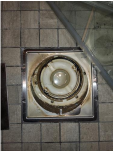
Tettesjiktets tilslutning til sluk - Sluk Baderom U.etasje.
