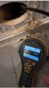
Kontroll i lukkede konstruksjoner - Fuktmåling utlektet vegg
