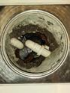
Tettesjiktets tilslutning til sluk - Sluk bad kjeller
