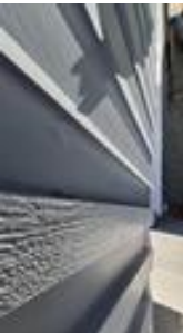
Ytterkledning (fasademateriale, vannbord, utvendig listverk, o.l.) - Boble overflatebehandling
