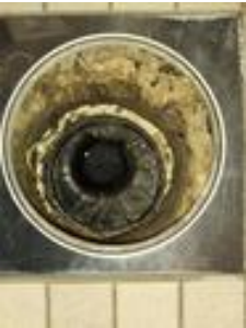
Tettesjiktets tilslutning til sluk - Sluk dusjnise, bad 2.etasje
