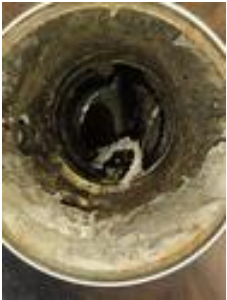
Tettesjiktets tilslutning til sluk - Sluk utenfor dusjsonen, bad 2.etasje
