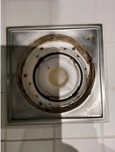
Tettesjiktets tilslutning til sluk - Sluk i dusjsonen.
