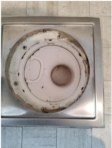
Tettesjiktets tilslutning til sluk - Sluk i dusjsonen.
