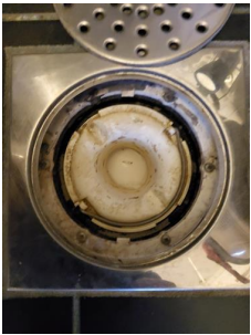
Tettesjiktets tilslutning til sluk - Sluk.
