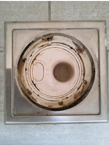
Tettesjiktets tilslutning til sluk - Sluk under badekar.
