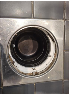
Vanntett sjikt / membran i gulv og vegger - Sluk i baderom.
