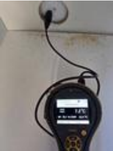
Utført kontroll i tiliggende konstruksjon - Fuktmåling bad
