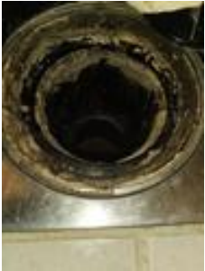
Tettesjiktets tilslutning til sluk - Sluk bad
