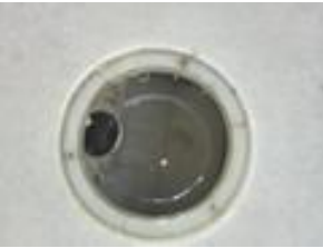
Tettesjiktets tilslutning til sluk - Sluk
