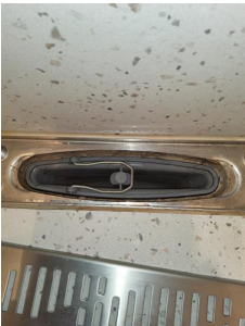
Tettesjiktets tilslutning til sluk - Sluk dusjsonen
