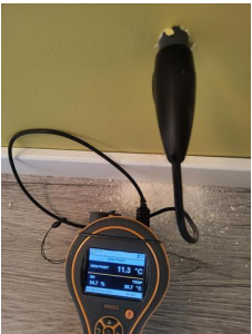
Utført kontroll i tilliggende konstruksjon - Fuktmåling
