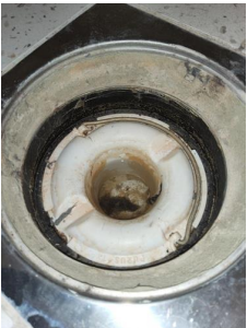
Tettesjiktets tilslutning til sluk - Sluk under badekar
