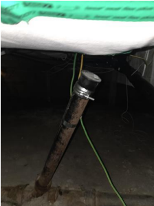
Innvendig stakeluke - Stakeluke krypkjeller
