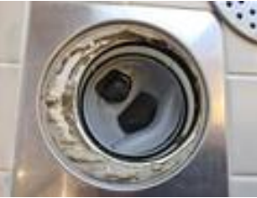
Tettesjiktets tilslutning til sluk - Sluk
