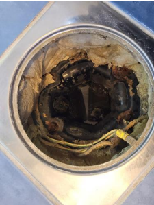
Tettesjiktets tilslutning til sluk - Sluk.
