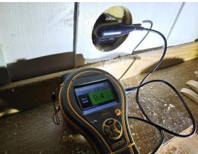
Utført kontroll i tiliggende konstruksjon - Fuktmåling bad
