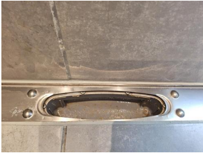
Tettesjiktets tilslutning til sluk - Sluk
