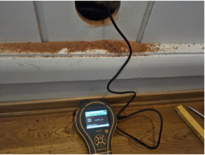
Utført kontroll i tiliggende konstruksjon - Fuktmåling bad
