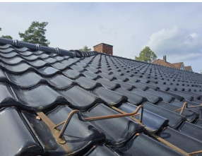
Tekking (med tilhørende beslag) - Taktekking.
