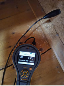
Utført kontroll i tilliggende konstruksjon - Fuktmåling bad
