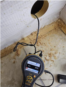
Kontroll i lukkede konstruksjoner - Fuktmåling kjellerstue
