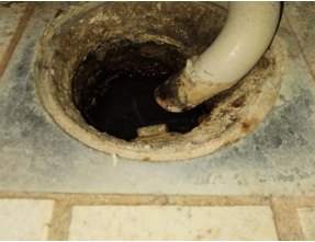
Tettesjiktets tilslutning til sluk - Sluk bad
