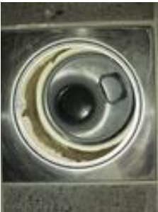
Tettesjiktets tilslutning til sluk - Sluk bad
